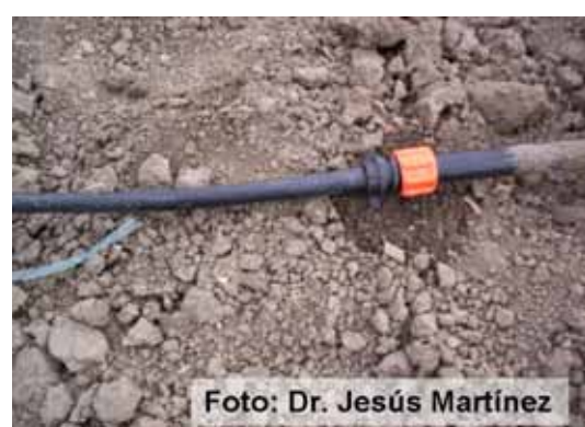
Tubería secundaria en el sistema de riego por goteo, se observa la conexión del tubín en la manguera lay-flat de dos pulgadas (izquierda). Posterior al tubín va conectada la cintilla de riego (derecha).
